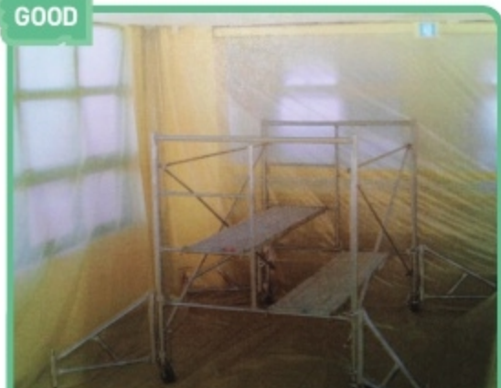
지지틀(아우트리게) 설치로 넘어짐 재해 예방
